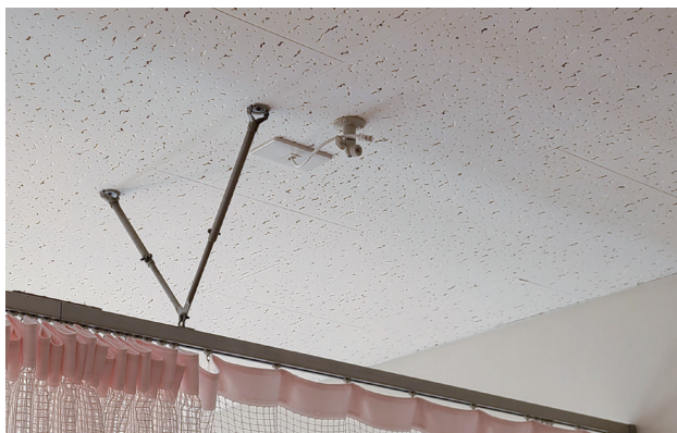
機器移動や増設を見越した配線工事
